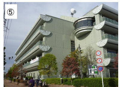
⑤ 横浜上麻生線沿いに集積する公共・公益施設（青葉区役所）
