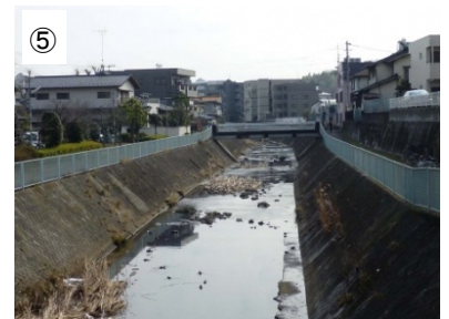
⑤ 早瀬川の両側には歩道があり、 駅周辺の貴重な親水空間
