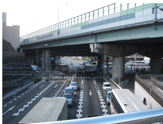
国道 246 号線は幹線道路であるとともに、江田駅周辺の生活道路としても利用されています
