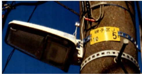
図 3-1 管理用名称札のサンプルと設置写真
