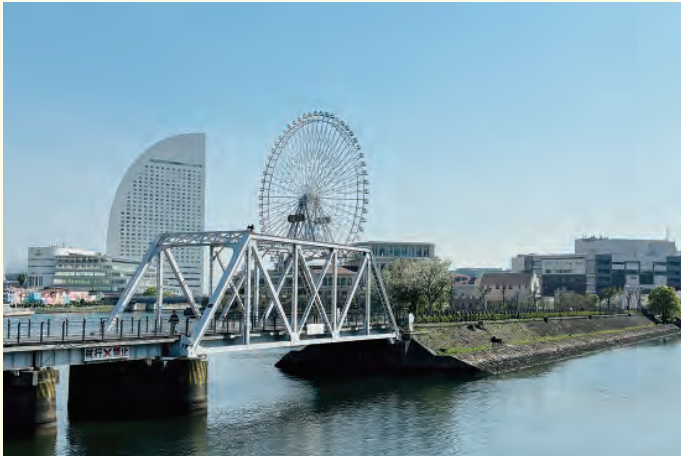
汽公道…新港ふ頭と現・桜木町駅（旧・横浜駅）を結ぶ貨物鉄道路線を生かしたプロムナード。平成9（1997）年完成。三つの橋梁及び二つの島の護岸が歴史的建造物として認定されている。プロムナード中の鉄道路線は当初から保全されているもの。
