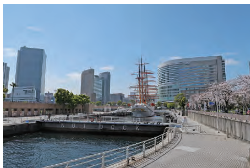
旧横浜船渠株式会社第一号船渠（ドック）
