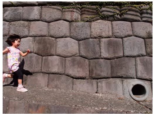
旧平沼専蔵別邸亀甲積擁壁
