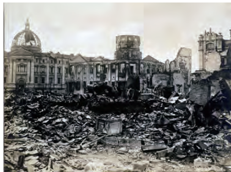
被災の様子（本町通り）
