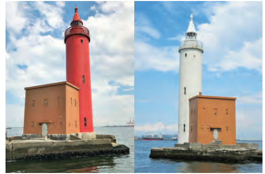
旧横浜外防波堤北灯台及び南灯台
