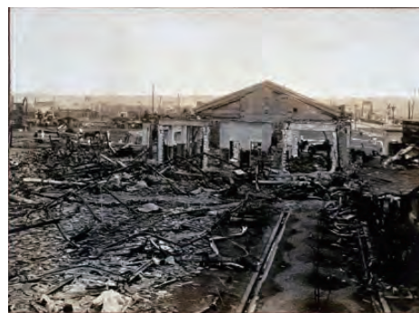
被災の様子（桜木町駅）
