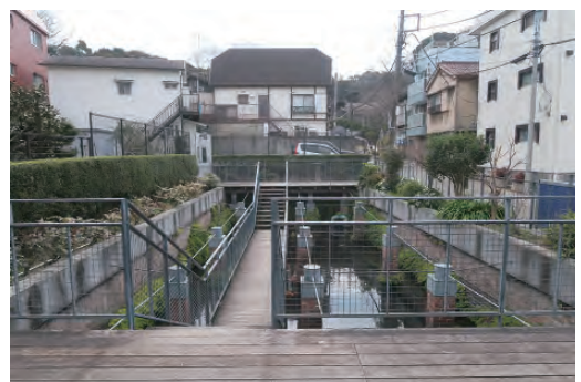
ジュラール水屋敷地下貯水槽
