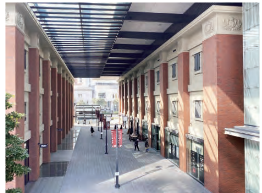
旧横浜生糸検査所附属生糸絹物専用 B号倉庫及びC号倉庫
