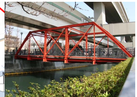
震災復興橋である浦舟水道橋 (登録 歴史的建造物)
