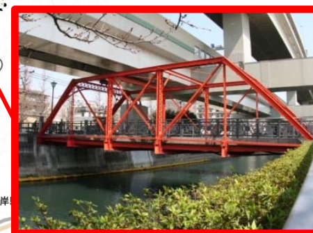
震災復興橋である 浦舟水道橋 (登録 歴史的建造物)
