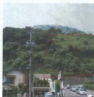
経過写真(平成19年)
