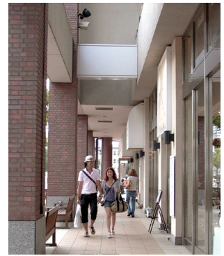
1階部分の壁面後退
