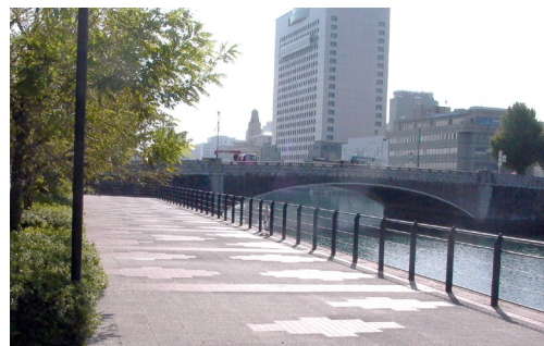
橋詰め空間（万国橋）
