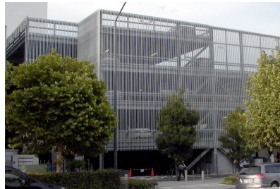
街並みの連続性を確保するためにルーバーを設けた立体駐車場の事例（中央地区）
