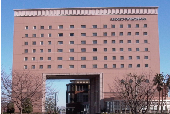
落ち着いた高層部の壁面看板
