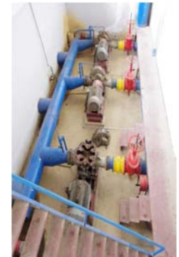
浄水場ポンプの 現地調査の様子
