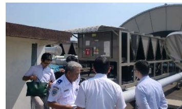
空港の空 調機器の 現地調査 の様子
