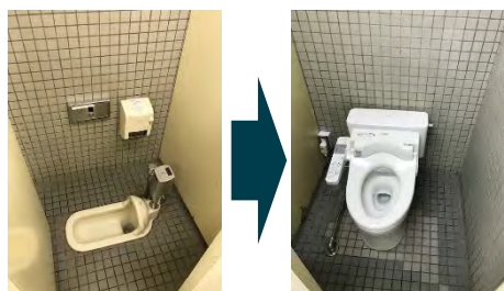
2F女子トイレ洋式化工事
