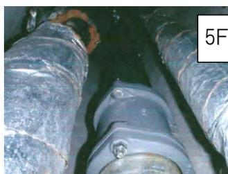
5F 雨水配水管漏水
