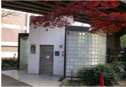
<関内駅南口公衆トイレ>
