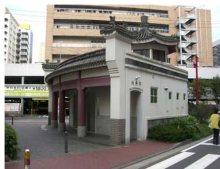
<山下町公衆トイレ>
