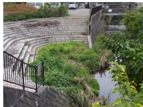
<愛護会が結成されていない階段護岸>
