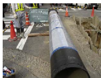
管が直接、土に触れないようにポリエチレンスリーブを施した配水管
