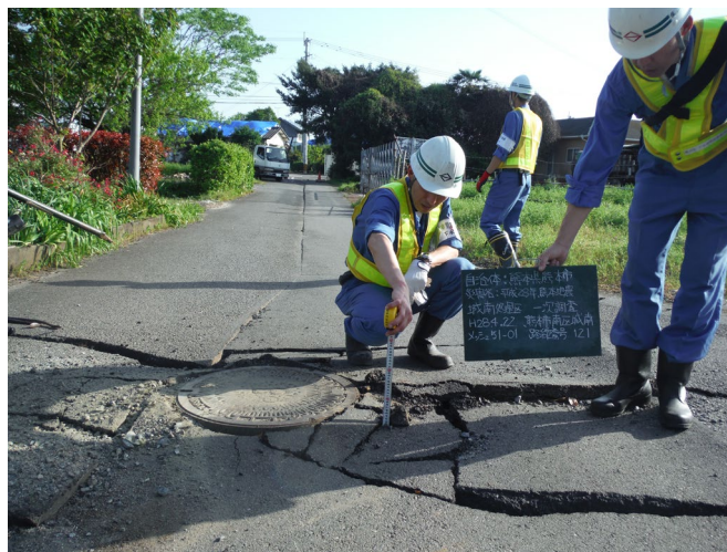
熊本地震時の管きよ調査の様子
