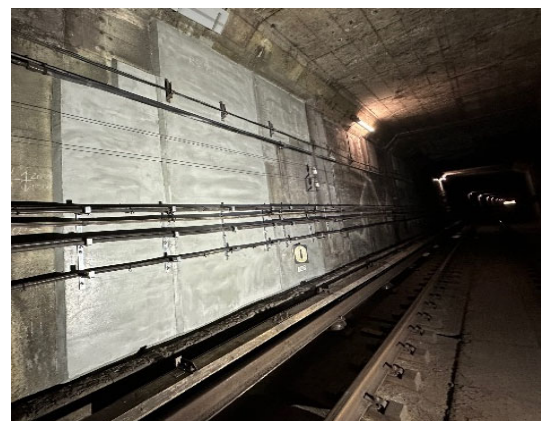
<開削トンネルの補修>
