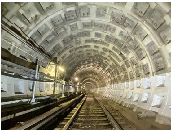
<シールドトンネルの補修>
