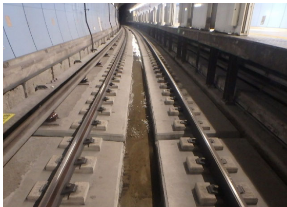
<軌道改良工事施工後>
