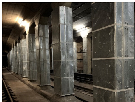
<開削トンネル部>
