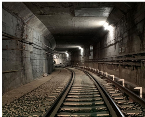
<急曲線軌道改良工事施工後>
