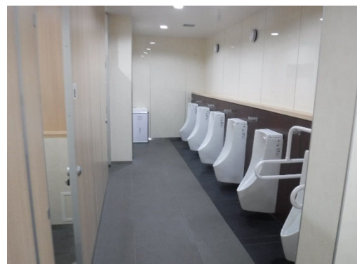
<センター南駅（6年度施工）>
