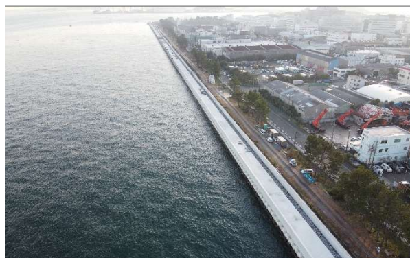
【金沢区福浦地区護岸復旧状況】
