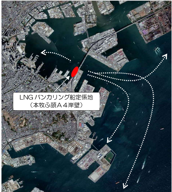
【本牧ふ頭のLNGバンカリング拠点】
