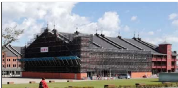
【赤レンガ倉庫の改修状況】
