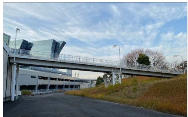
【現在の仮設デッキ】
