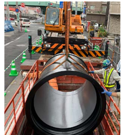
耐震管への更新工事
