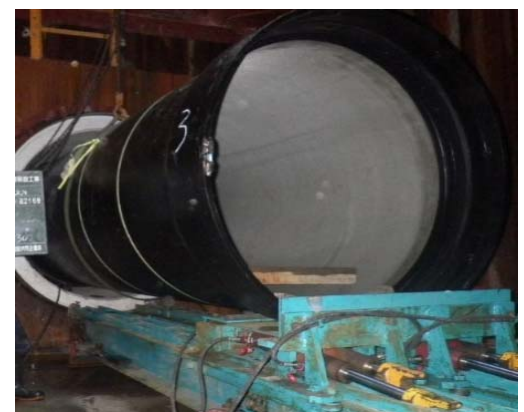
大口径管路更新工事
