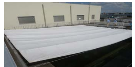
建築用養生シートによるろ過池覆蓋の様子 (埼玉県企業局大久保浄水場)
