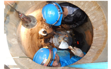
仕切弁点検調査の様子
