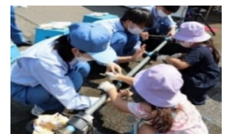
漏水修理体験の様子 (水道週間)
