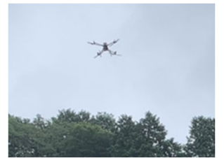
ドローン作業風景
