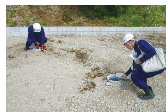
雨水流出抑制施設完了検査の様子
