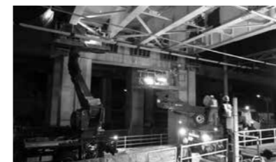
橋梁の保全工事
