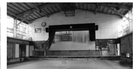
小学校体育館の改修工事
