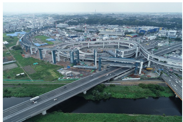
横浜環状北西線（川向地区）
