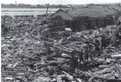
伊勢湾台風の被害状況
