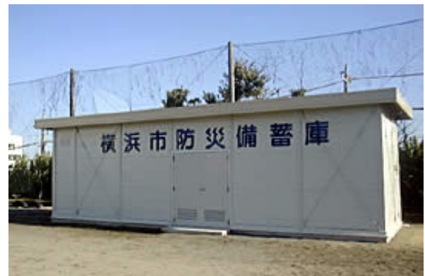
地域防災拠点の防災備蓄庫
