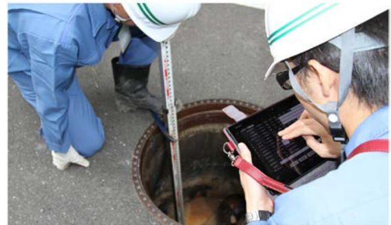
公民連携で開発したシステムを利用した 下水道管実地調査訓練
