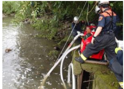
河川からの取水の様子
