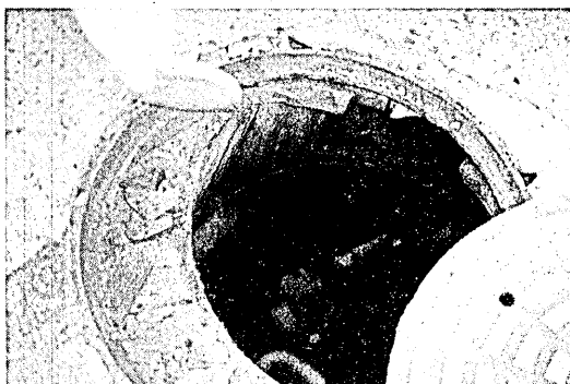
写真-1 マンホールの損傷
