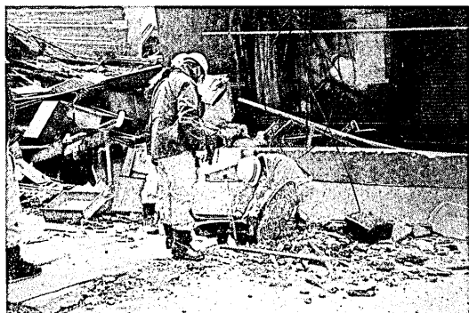
写真-2 マンホールと管きよの異常を調べる目視検査
