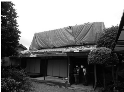
写真4 建築物被害認定調査の様子
