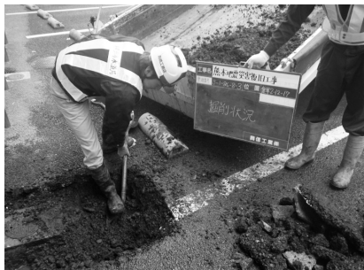
写真6 水道管復旧の様子
