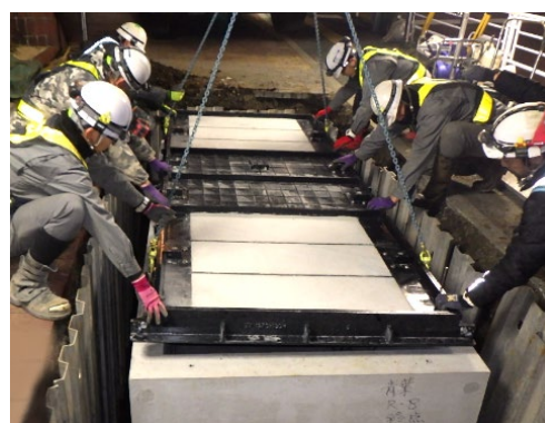
特殊部設置状況
