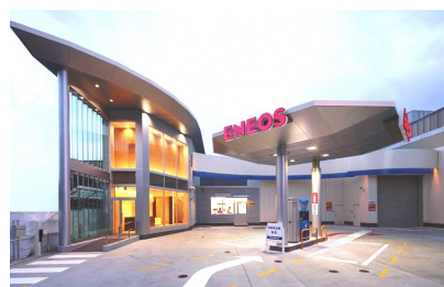
ENEOS 横浜綱島水素ステーション
