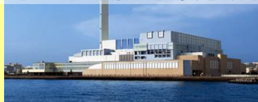
「資源循環局・金沢工場」
