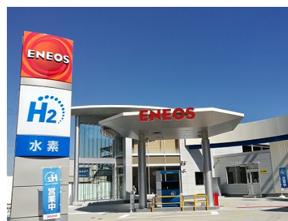
横浜綱島水素ステーション
