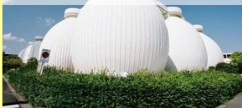
「環境創造局・汚泥資源化センター消化タンク」
