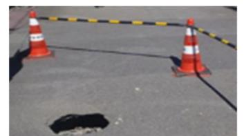
取付管破損による道路陥没
