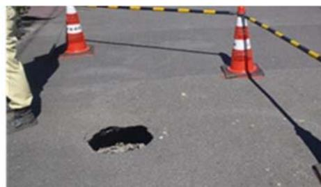
Zパイプ破損による道路陥没
