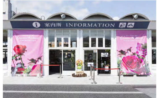
Park-PFI によりリニューアルする 山下公園レストハウス
