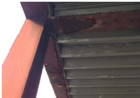
【上屋の梁部分】
