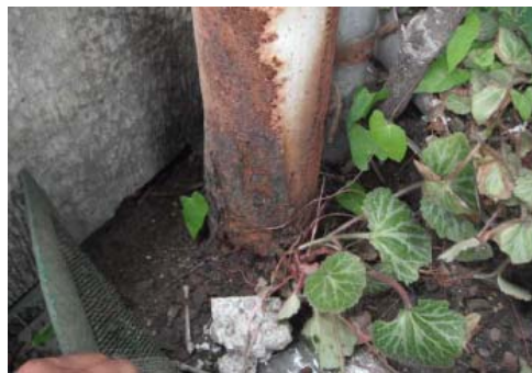
【上屋の支柱部分】
