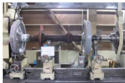
車輪交換作業
