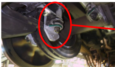
基礎ブレーキ装置
