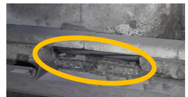
一部が破損しているコンクリートトラフ
