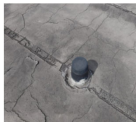
立場駅(駅舎屋上部)
