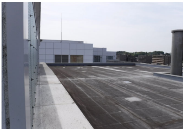
新羽保守管理所検車庫棟屋
