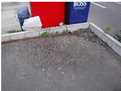
鳩フン被害状況
