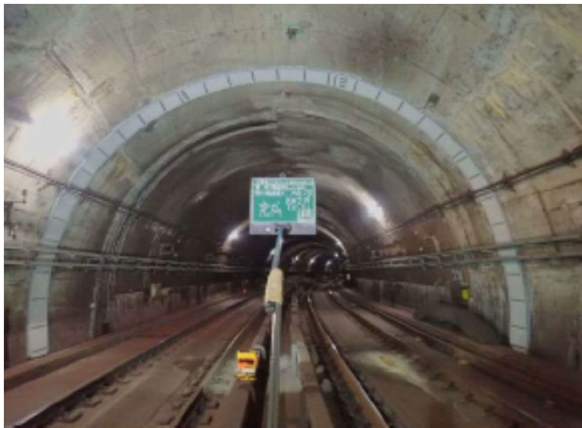
受け樋設置工
