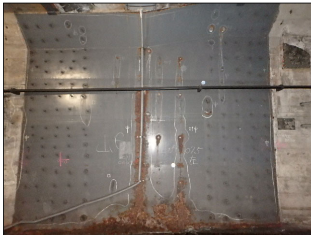
▲関内・長者町ケーソン耐震鋼板 上り
