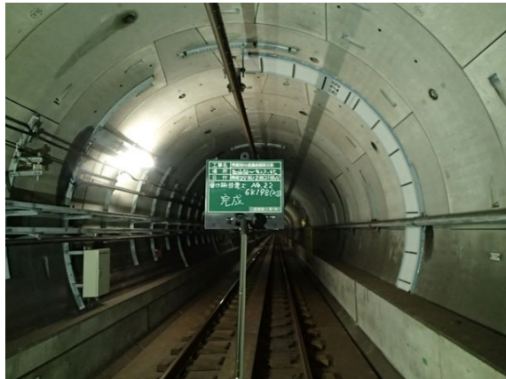
受け樋設置工
