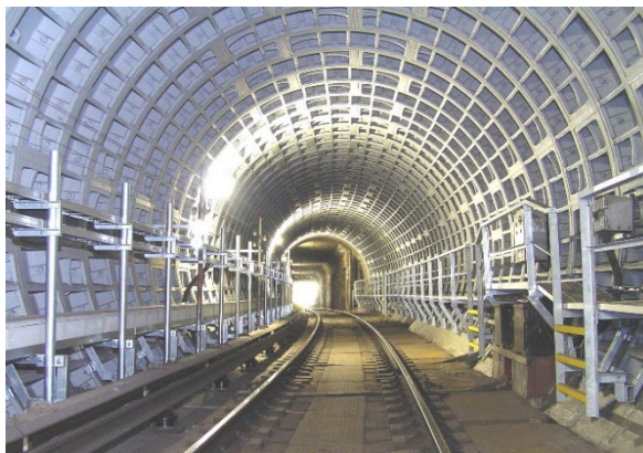
<シールドトンネルの補修>
