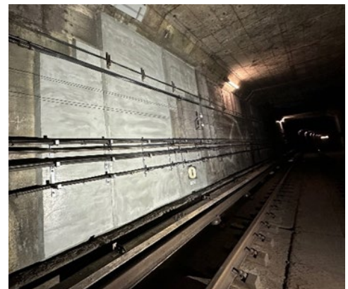
<開削トンネルの補修>
