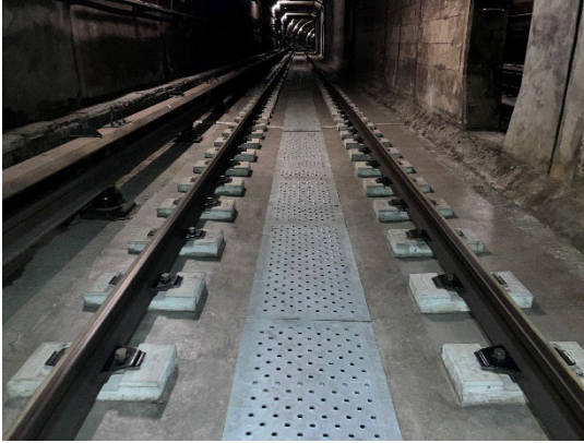
<軌道改良工事施工後>
