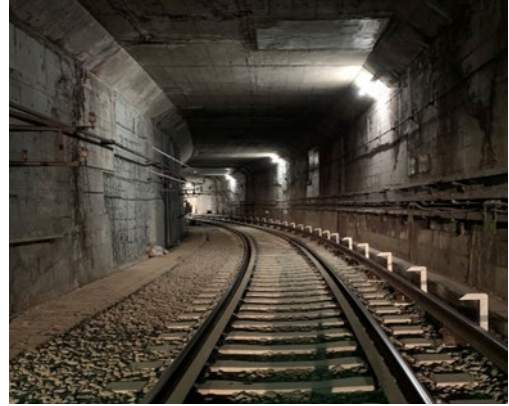
<急曲線軌道改良工事施工後>
