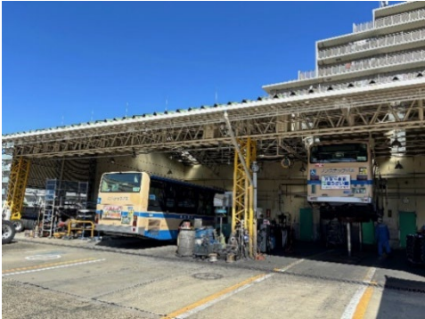
<緑営業所車両整備工場>
