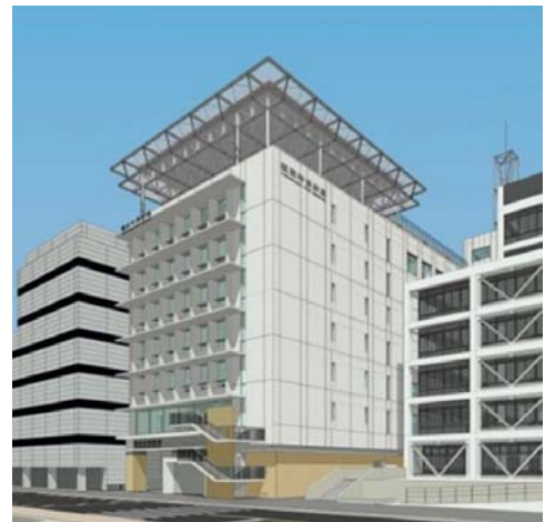
消防本部庁舎
