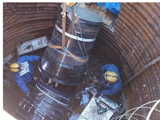
大口徑配水管布設替工事
