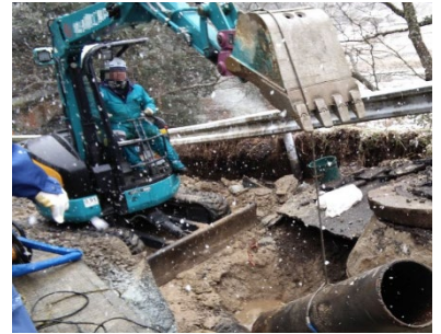
災害協定締結事業者による応急復旧
