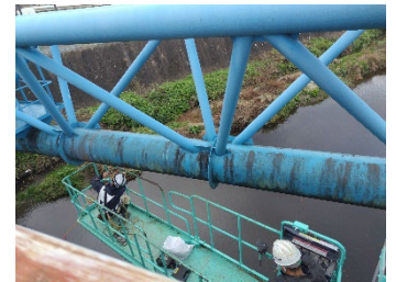
水管橋点検調査の様子
