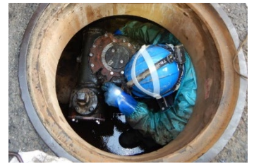
仕切弁点検調査の様子
