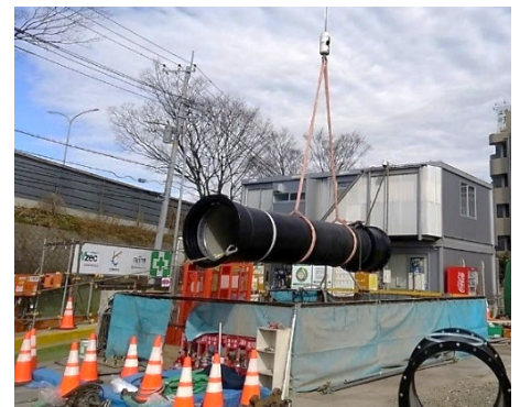
口径800mm配水管布設替工事
