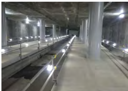
新横浜駅 ホーム階構築状況
