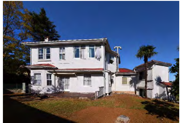
外観工事等助成 山手133番館(西洋館)
