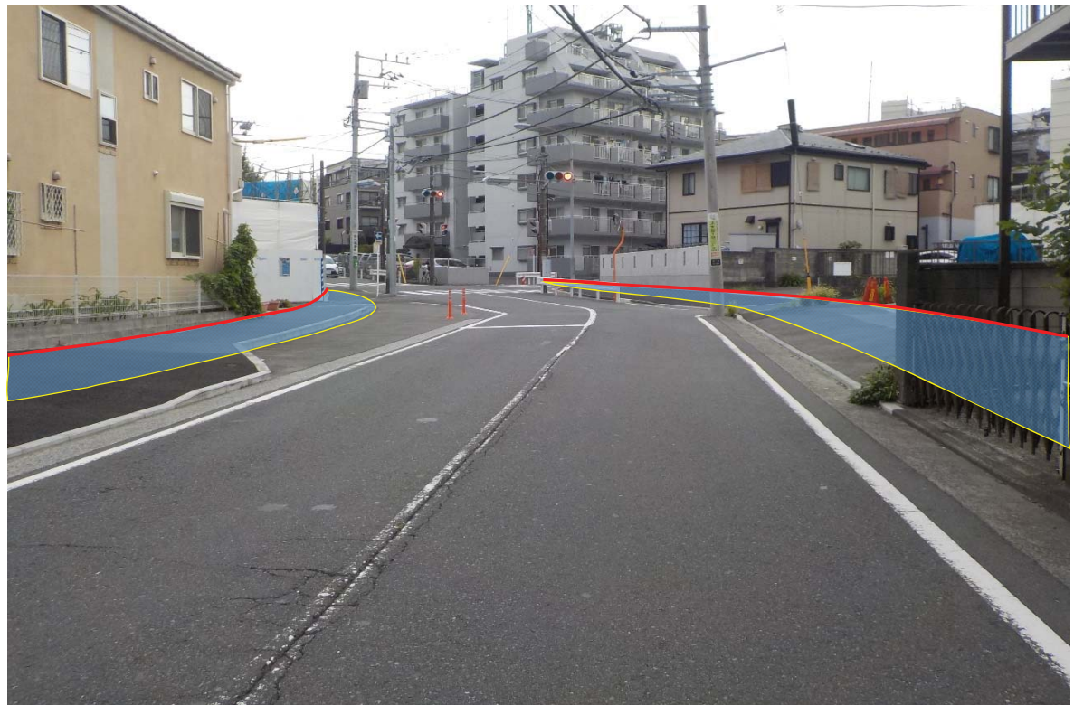
市道上大岡第149・168号線道路改良事業 写真④
