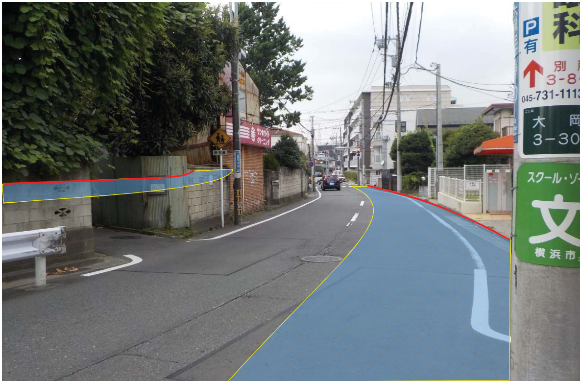
市道上大岡第149・168号線道路改良事業 写真⑧
