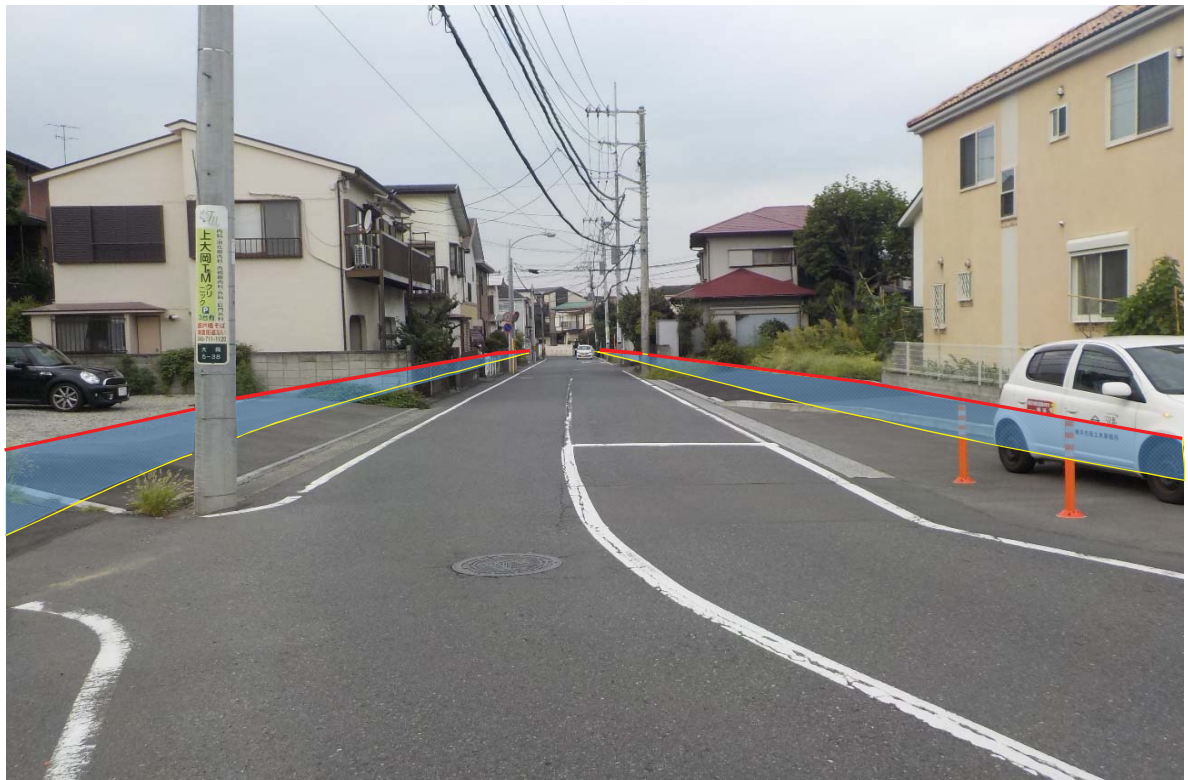
市道上大岡第149・168号線道路改良事業 写真⑥
