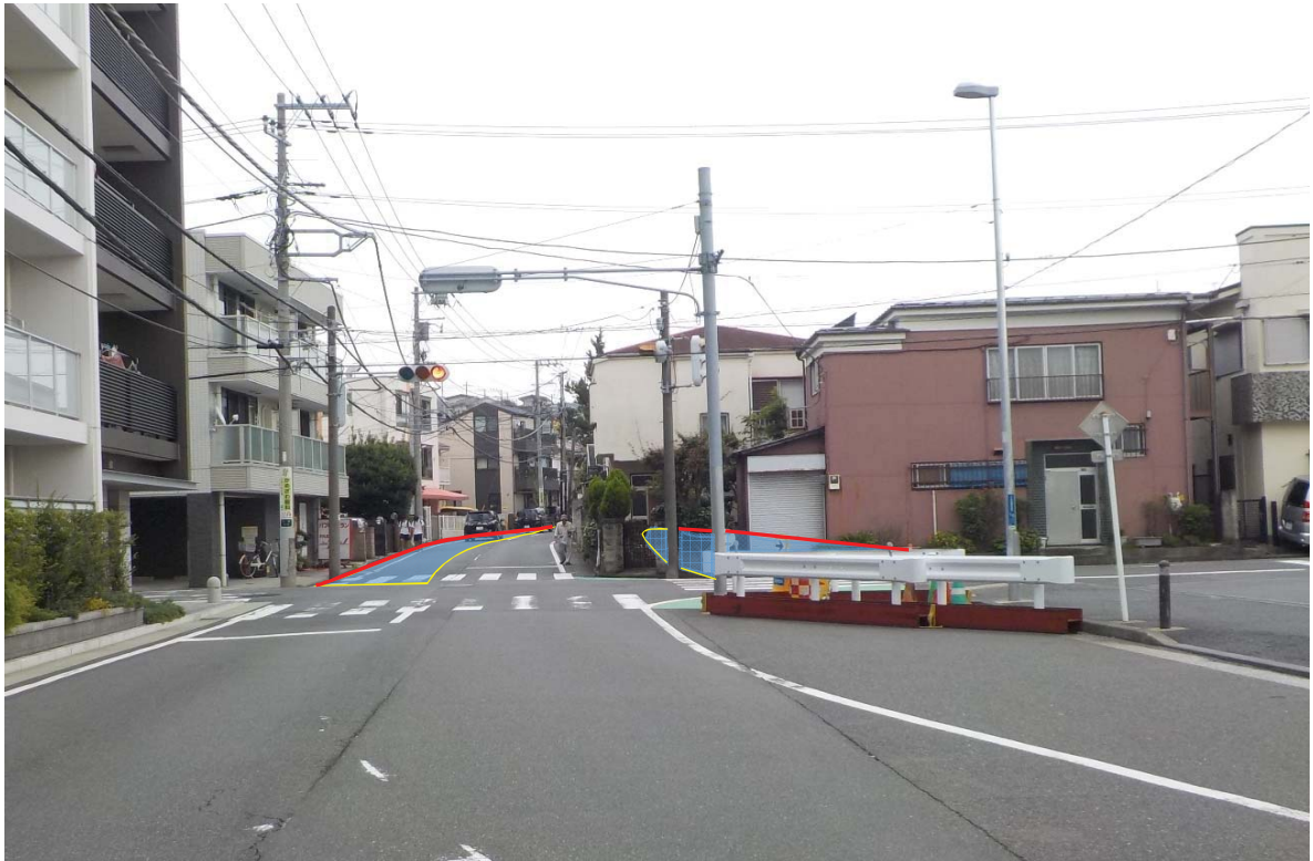
市道上大岡第149・168号線道路改良事業 写真①
