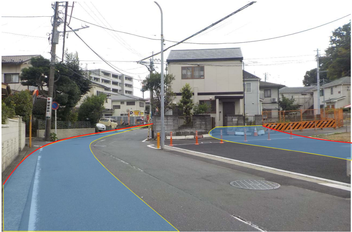
市道上大岡第149・168号線道路改良事業 写真③
