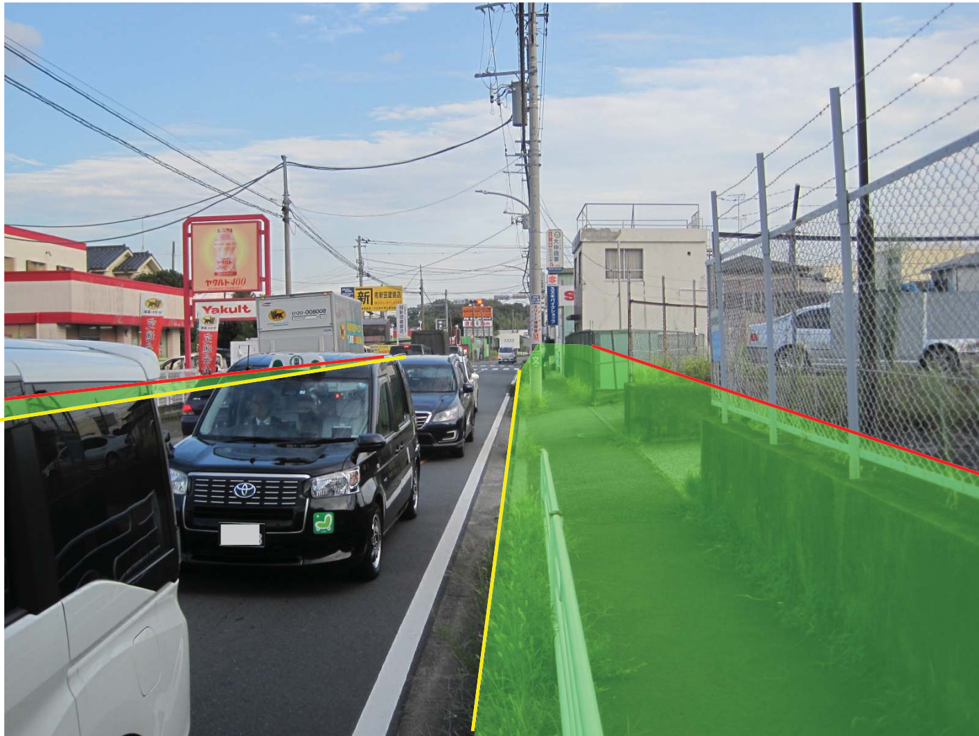
主要地方道横浜生田（柚の木交差点）改良事業 写真②
