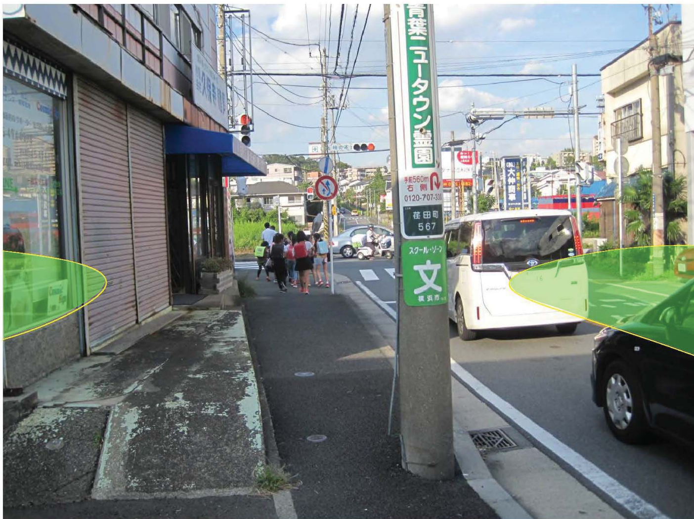
主要地方道横浜生田（柚の木交差点）改良事業 写真⑥
