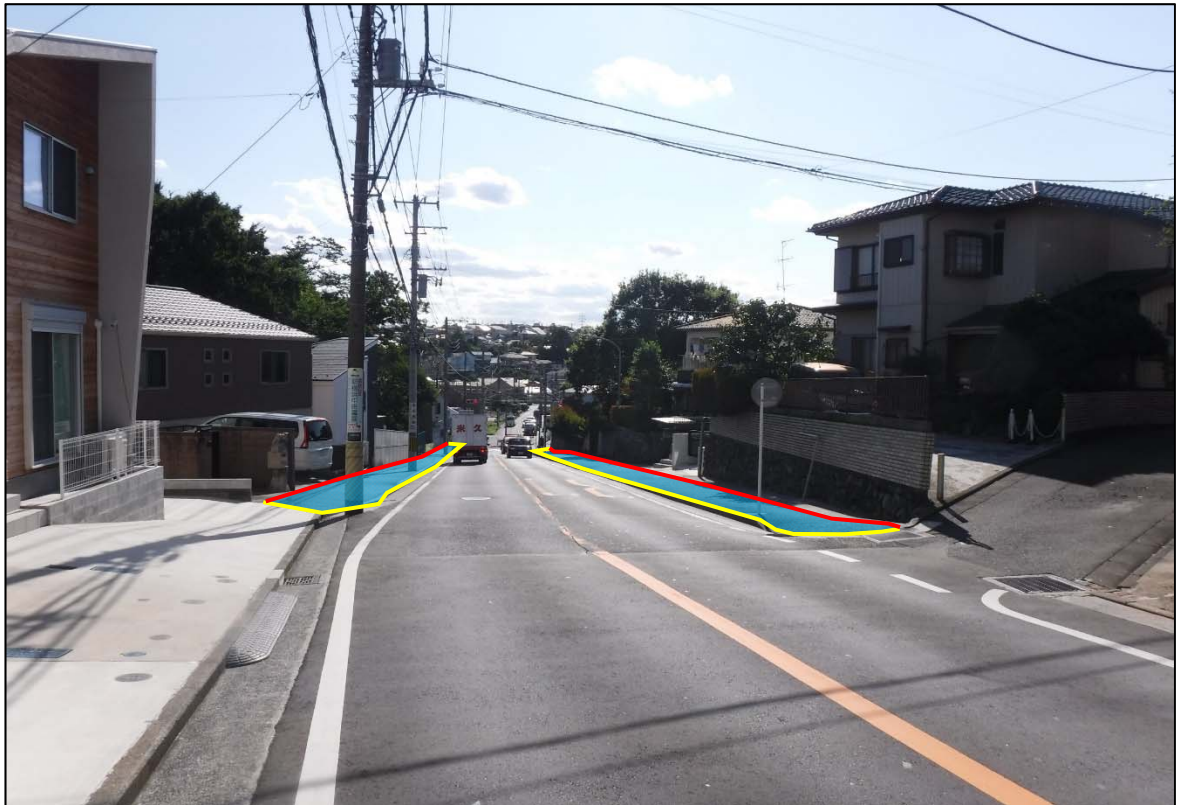
県道青砥上星川(上菅田地区)道路改良事業 写真⑤
