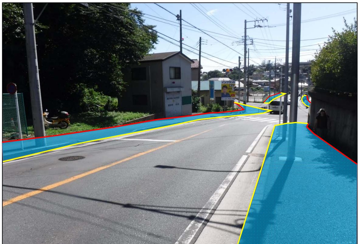
県道青砥上星川(上菅田地区)道路改良事業 写真⑥
