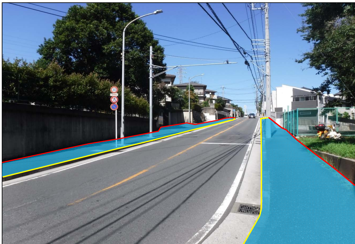
県道青砥上星川(上菅田地区)道路改良事業 写真④
