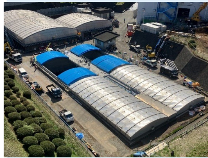
写真4 排泥池の補修
