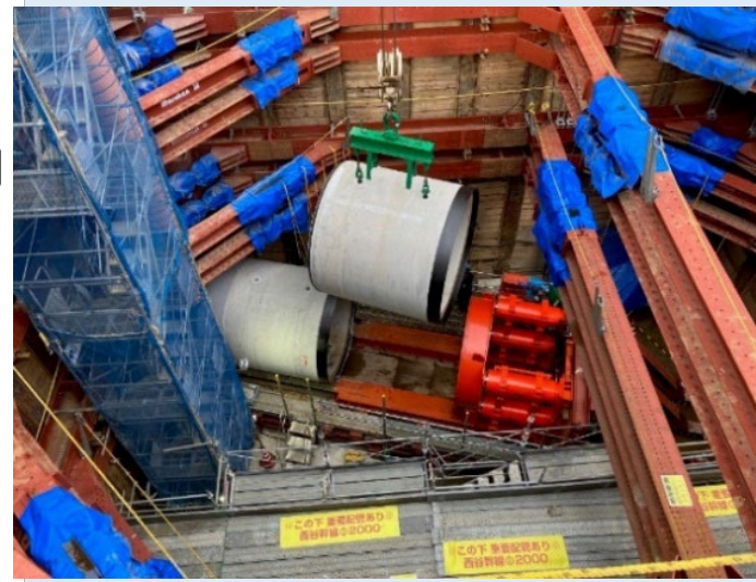
写真2 場内管路切り回し工
