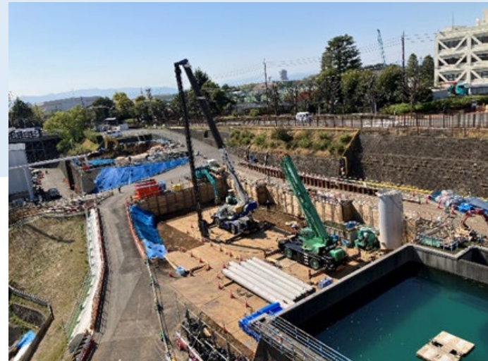
写真3 排水池の築造
