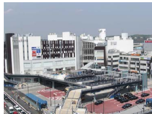
戸塚駅西口全景
