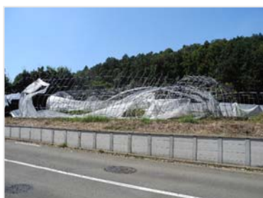
ビニールハウス全壊
