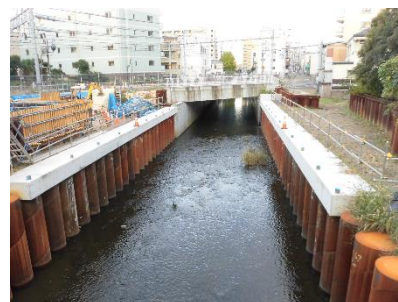
河川改修による護岸整備（今井川）
