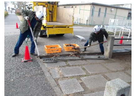
＜側溝の清掃作業＞
