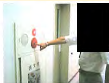
【日常点検の様子】
