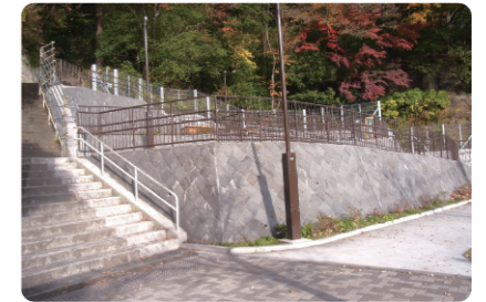
津波避難施設
