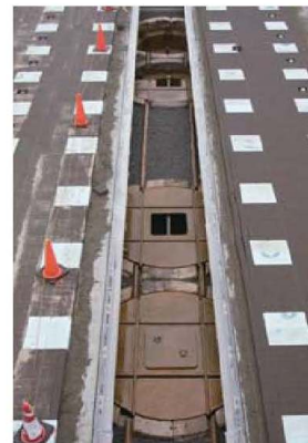
▲工事中の転車台
