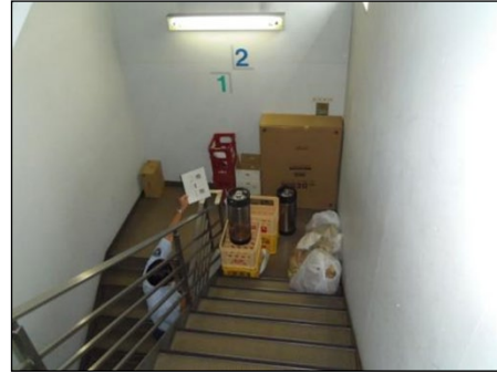
階段に物件が置かれている様子
