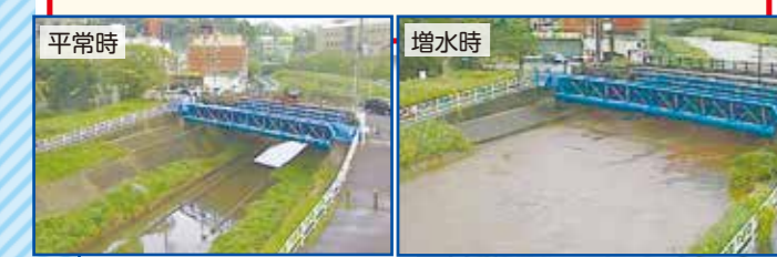
増水する鳥山川又口橋付近
